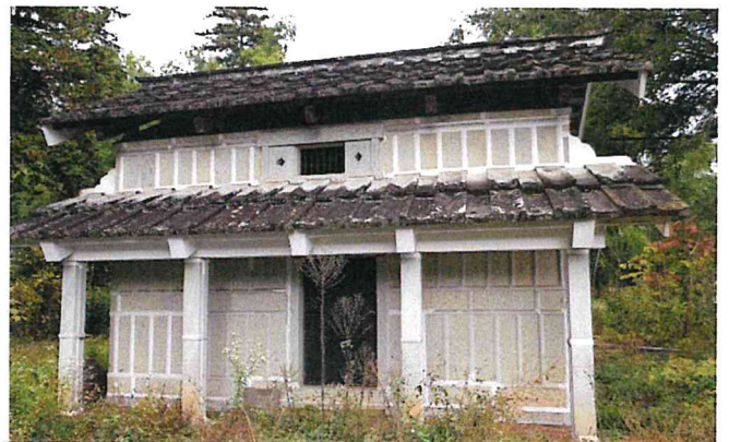
市井の石工や大工の建造物 徳次郎西根庄屋蔵
